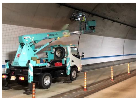
照明設備 球替え作業中
