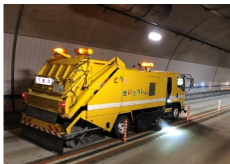
路面清掃 作業中
