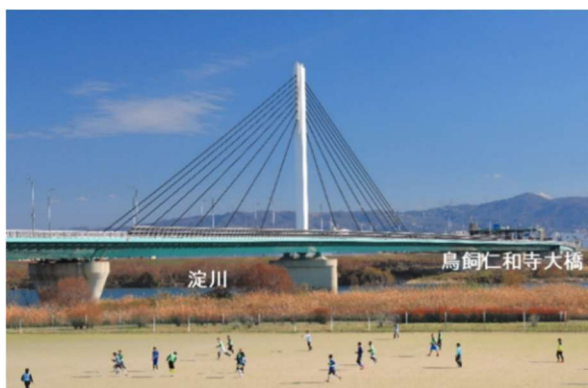
写真-1 鳥飼仁和寺大橋有料道路
