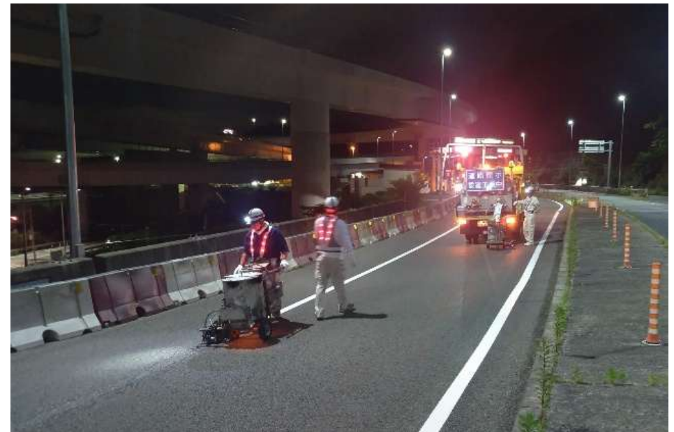
路面標示修繕。トンネル北坑口部の安全対策
