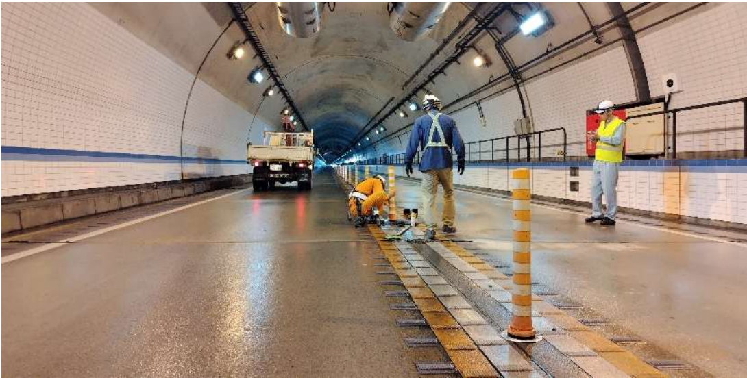
対面通行を分離するラバーポールの損傷分を取替え
