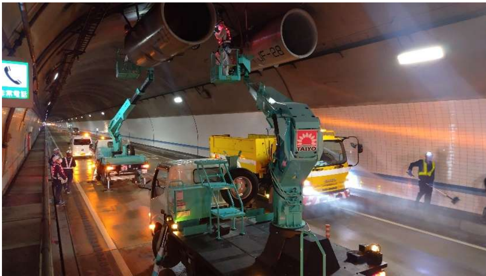
煙を制御するためのジェットファン設備の点検作業の様子。2台の高所作業車がペアになって、実施。また、反対車線では、壁面清掃車が通行中。
