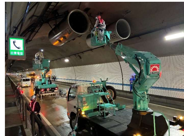
換気設備の点検
