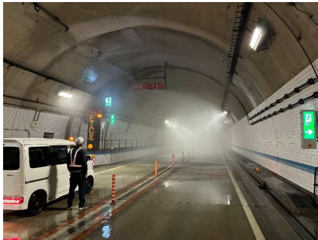
防災設備の点検
