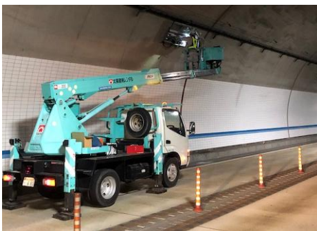
照明設備 球替え作業中
