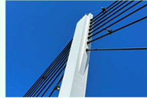
ケーブル詳細点検調査
