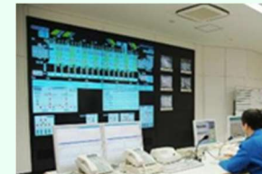
監視制御設備の更新
