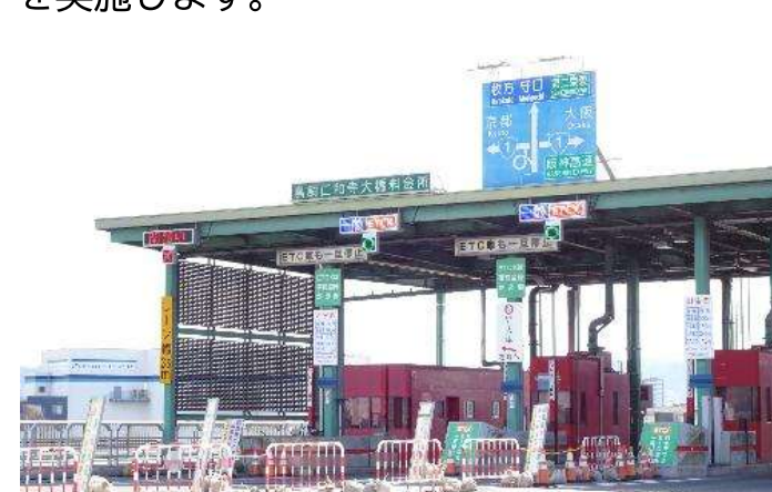
料金所及び設備機器の撤去
