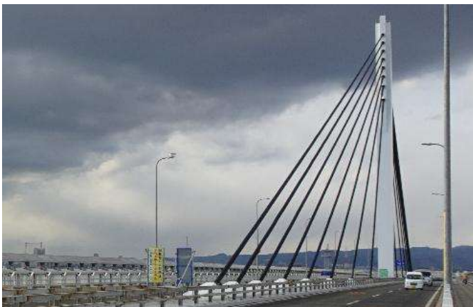
橋のケーブル詳細点検調査
