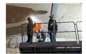
トンネル構造物補修
