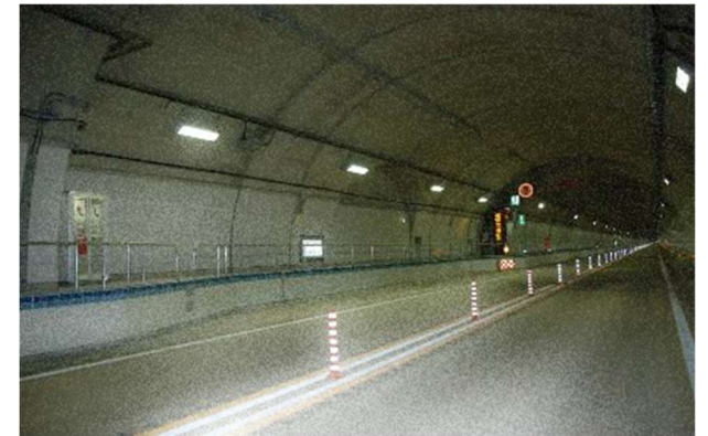
トンネル内の照明LED化(箕面)
