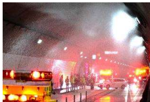
消火活動(水噴霧トンネル設備)
