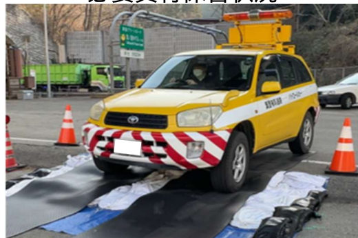
道路啓開作業
