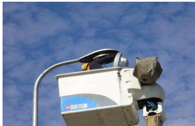
道路照明灯具の補修
