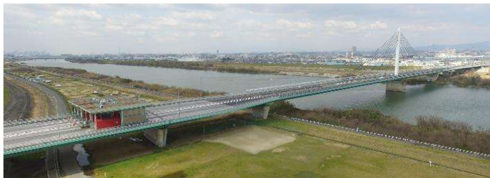
鳥飼仁和寺大橋有料道路の全景
