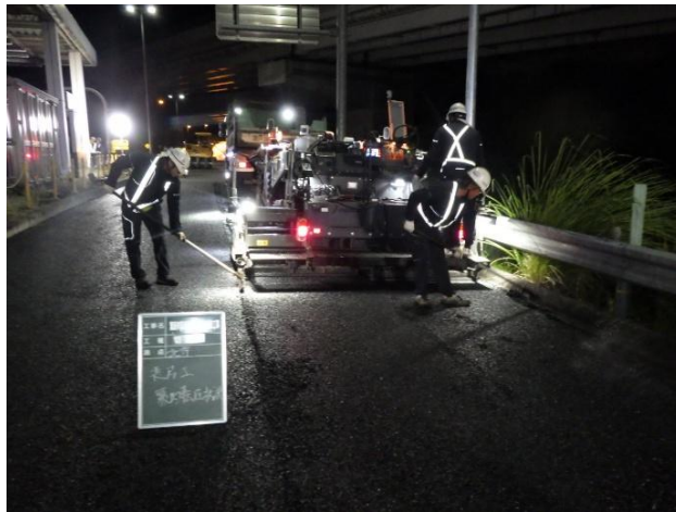
舗装補修工事
