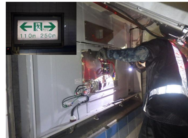
避難誘導灯交換
