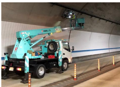
照明設備 球替え作業中
