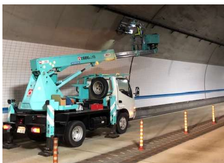
照明設備 球替え作業中
