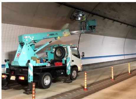
照明設備 球替え作業中
