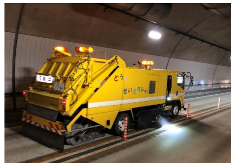
路面清掃 作業中
