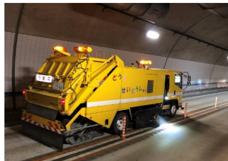
路面清掃 作業中
