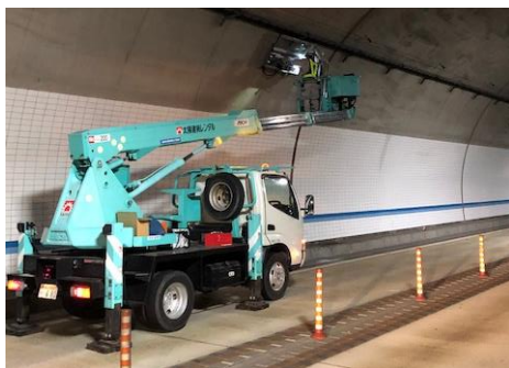
照明設備 球替え作業中
