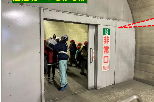
避難坑へつながる扉
