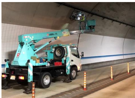
照明設備 球替え作業中
