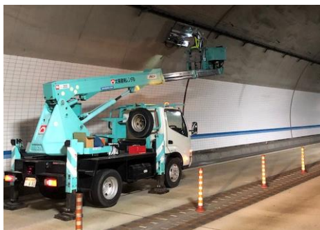
照明設備 球替え作業中
