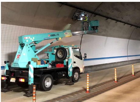
照明設備 球替え作業中
