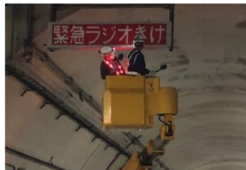
防災設備 点検作業中
