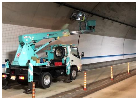
照明設備 球替え作業中
