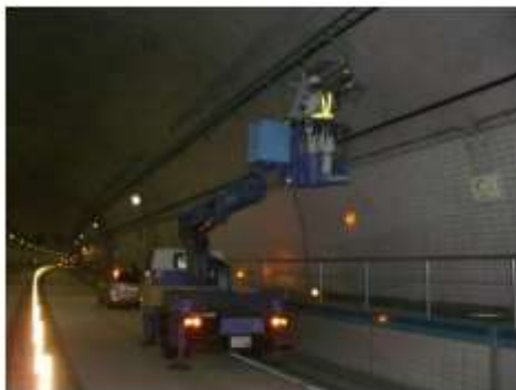
照明設備 点検作業中
