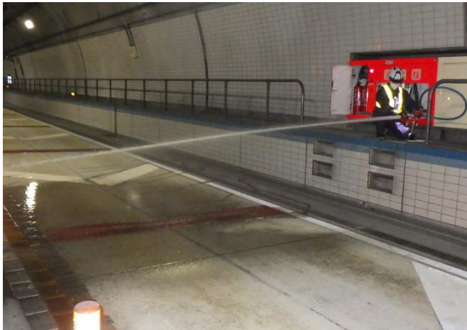
消火栓放水点検
