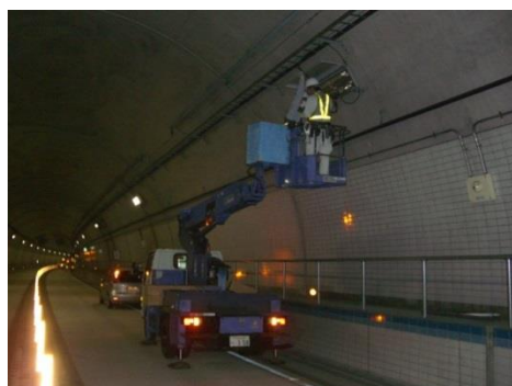
照明設備 点検作業中
