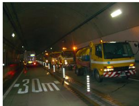
路面 清掃作業中
