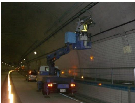
照明設備 点検作業中
