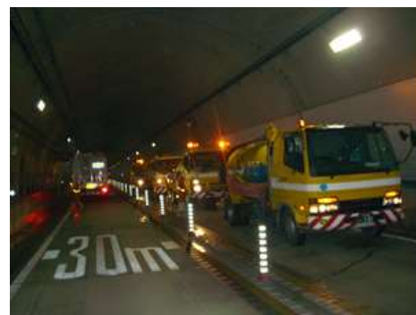
路面 清掃作業中
