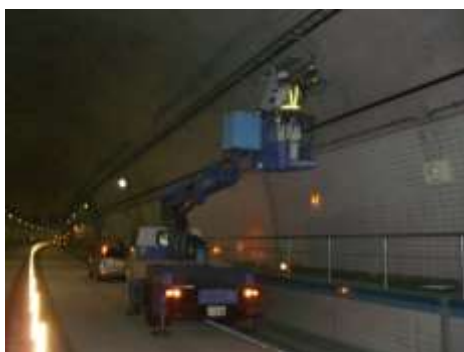
照明設備 点検作業中
