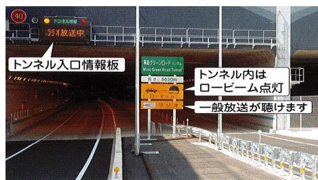
○トンネル入口及びトンネル内の情報板を確認する
