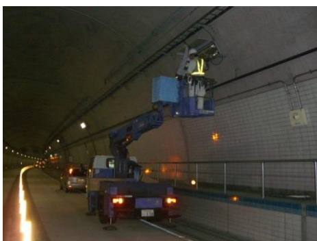
照明設備 点検作業中
