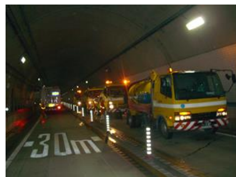
路面 清掃作業中
