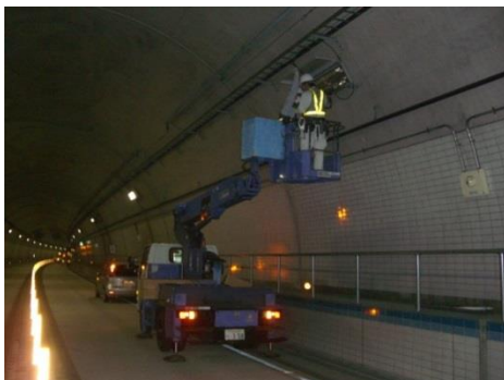
照明設備 点検作業中
